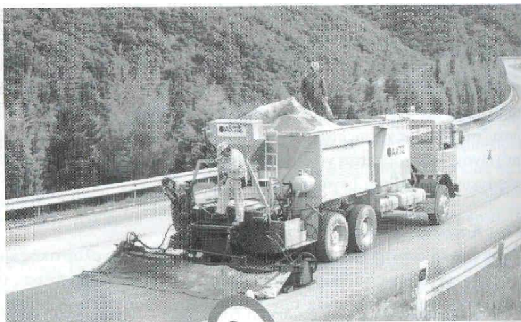
Φωτογραφία 1. Μηχάνημα παραγωγής και διάστρωσης μιγμάτων slurry
